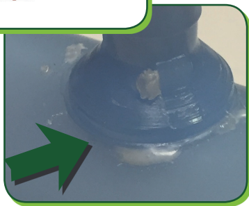
Apparition du cordon de soudure
