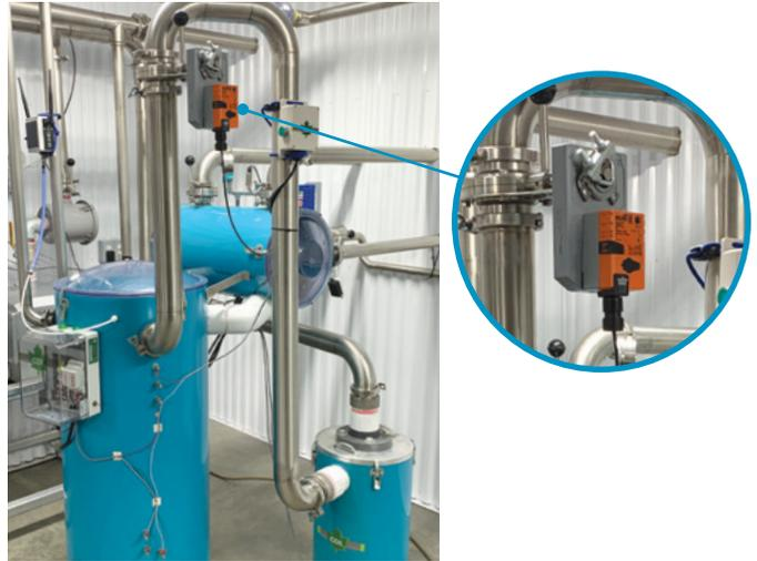
La valve de protection empêche sécuritairement le surplus de sève d'atteindre la tuyauterie allant à la trappe d'humidité ou à votre pompe vacuum lors d'un coup d'eau sans interrompre le vacuum.
